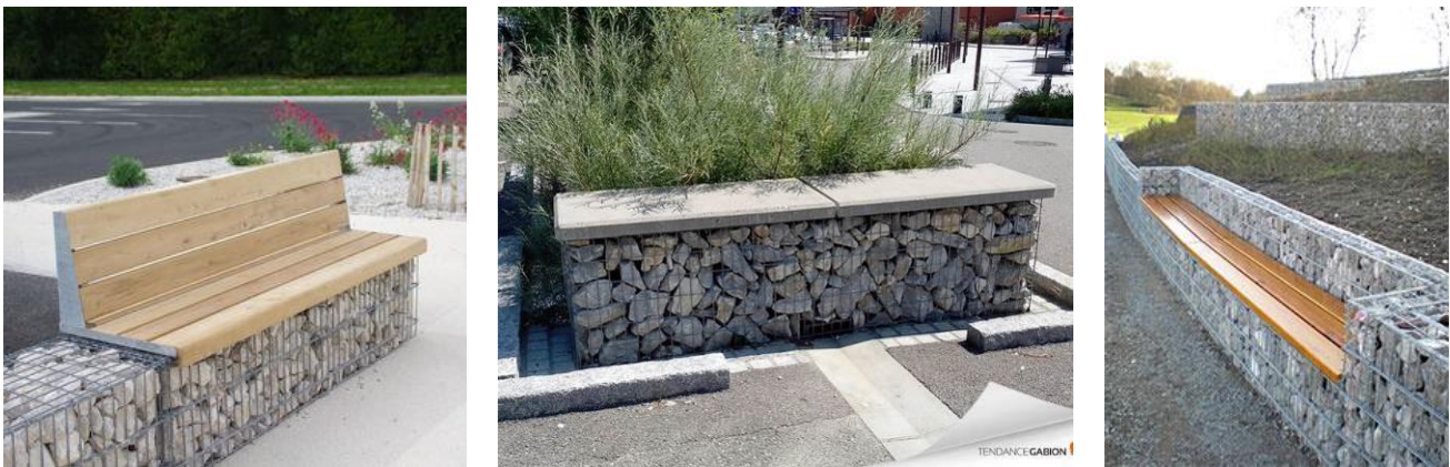
Figure 35 : Exemple de bancs en gabions
