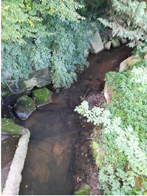
Photo 1 : Ru du Perray (transect AA') en aval immédiat d'un dalot sous voirie
